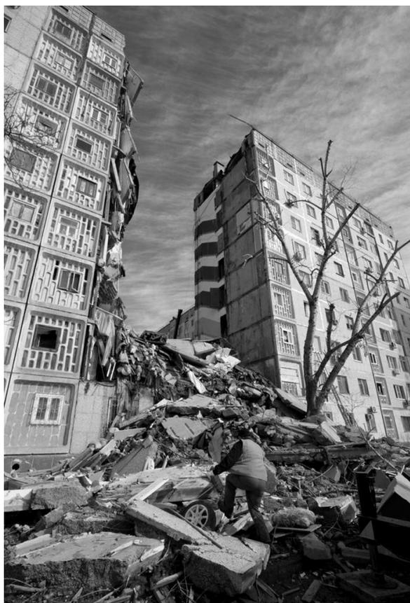
*Рис. 2. Взрыв бытового газа в многоэтажном жилом доме в Астрахани*
